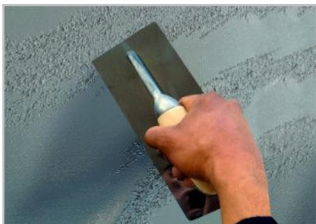
Étape 5 - Lorsque le produit commence à sécher procéder au compactage et phases de polissage.
